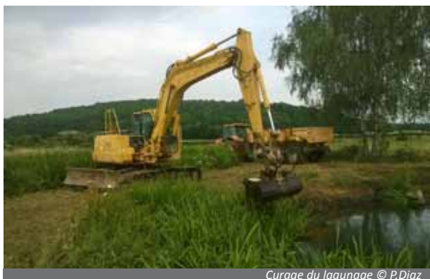
Curage du lagunage © P.Diaz
